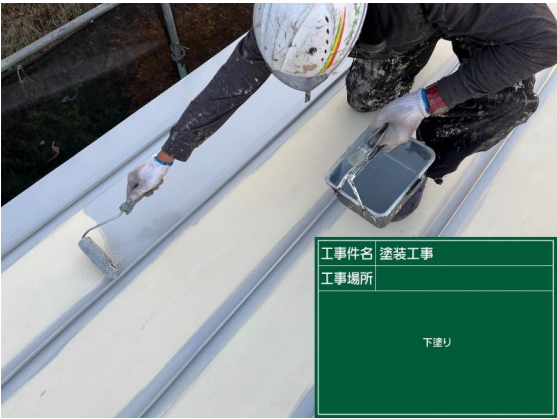
● 屋根 下塗り 錆止め グレー
