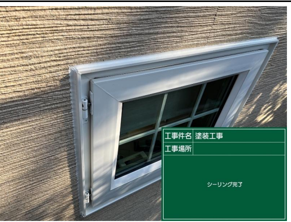
● シール工事 サッシ廻り シーリング完了
