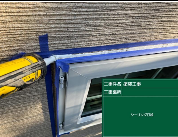
● シール工事 サッシ廻り シーリング打設
