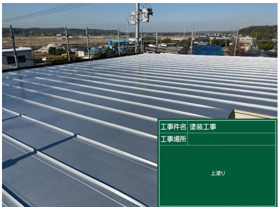
● 屋根 上塗り完了
