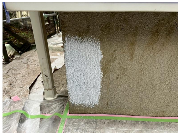
● 基礎 塗膜のハガレ部分 既存模様合わせ 主材塗り レナラックローラー用
