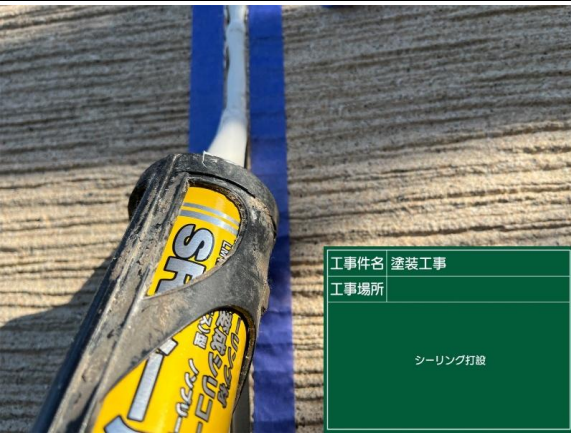
● シール工事 目地 シーリング打設
