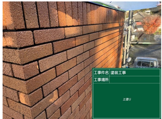
● 外壁 タイル面 上塗り完了 濡れ色が濃くなり表面にクリヤー層で保護
