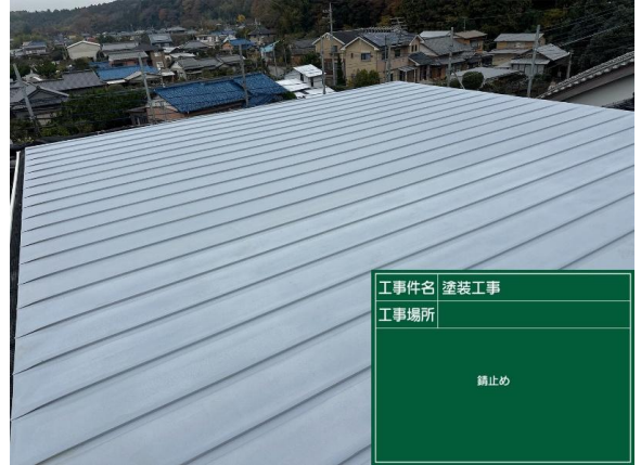
● 屋根 下塗り完了
