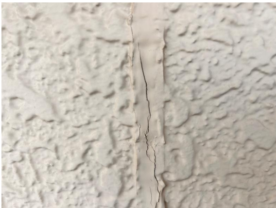
● 外壁目地 経年劣化でひび割れをしています 既存のシールを撤去した後にシーリングを 打ち直します
